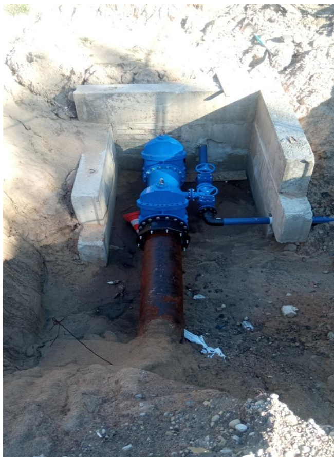
8 pav. Vandentiekio vamzdynų renovacijos darbai Kupiškių g.
