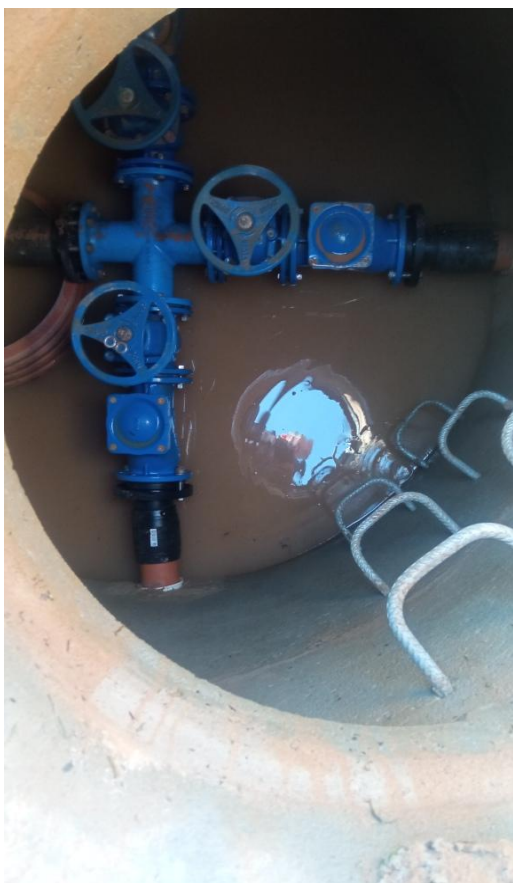
7 pav. Vandentiekio linijos statyba Gaspariškių g.
