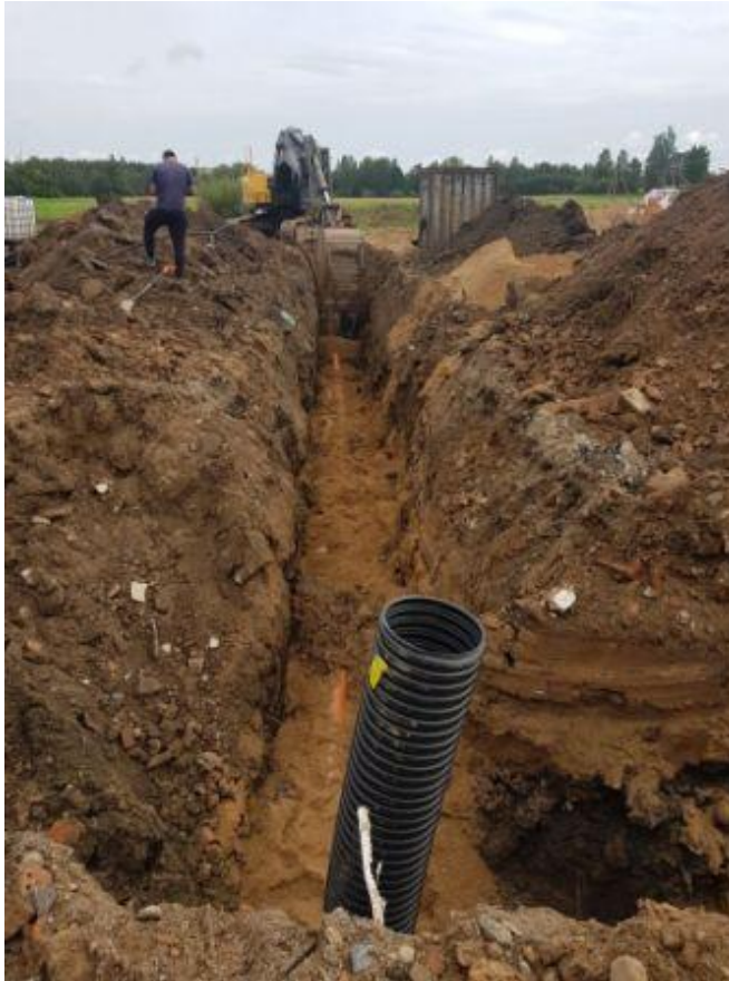
7 pav. Vandentiekio įvado ir nuotekų išvado statyba
