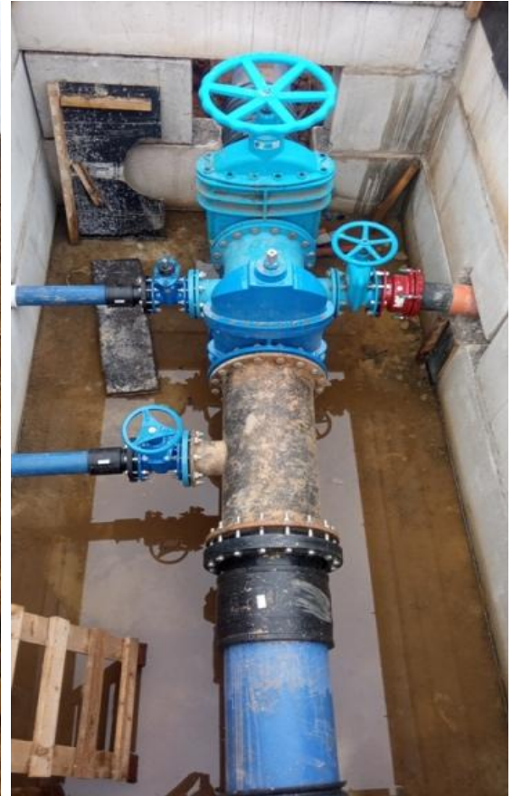
8 pav. Vandentiekio vamzdynų renovacijos darbai J.Basanavičiaus g.
