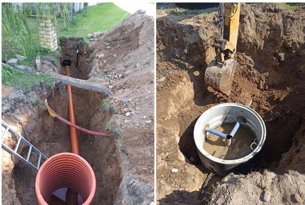
8 pav. Vandentiekio įvadų ir nuotekų tinklų išvadų statyba
