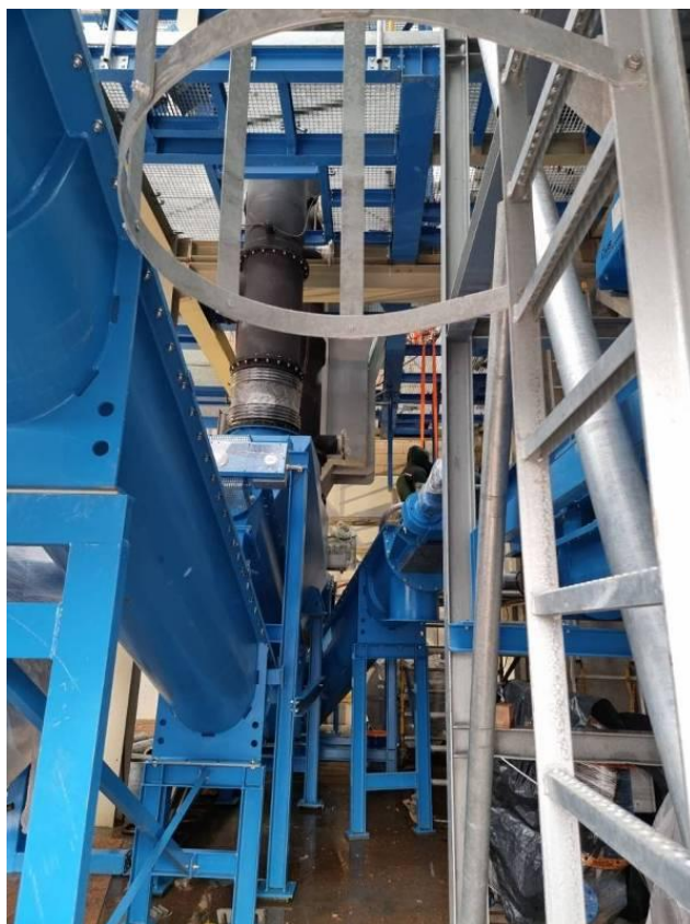
25 pav. Dumblo deginimo įrenginių statyba
