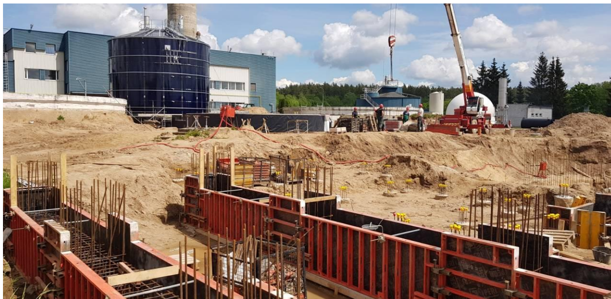
21 pav. Dumblo džiovavimo - deginimo pastatų statyba
