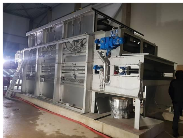
24 pav. Dumblo džiovavimo įrenginių statyba
