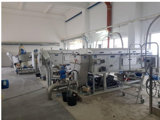
23 pav. Dumblo tankinimo įrenginių statyba
