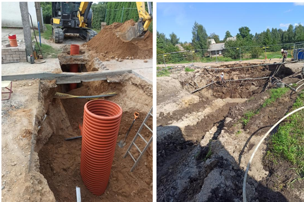
7 pav. Vandentiekio ir nuotekų tinklų statyba Saldutiškio kaime
